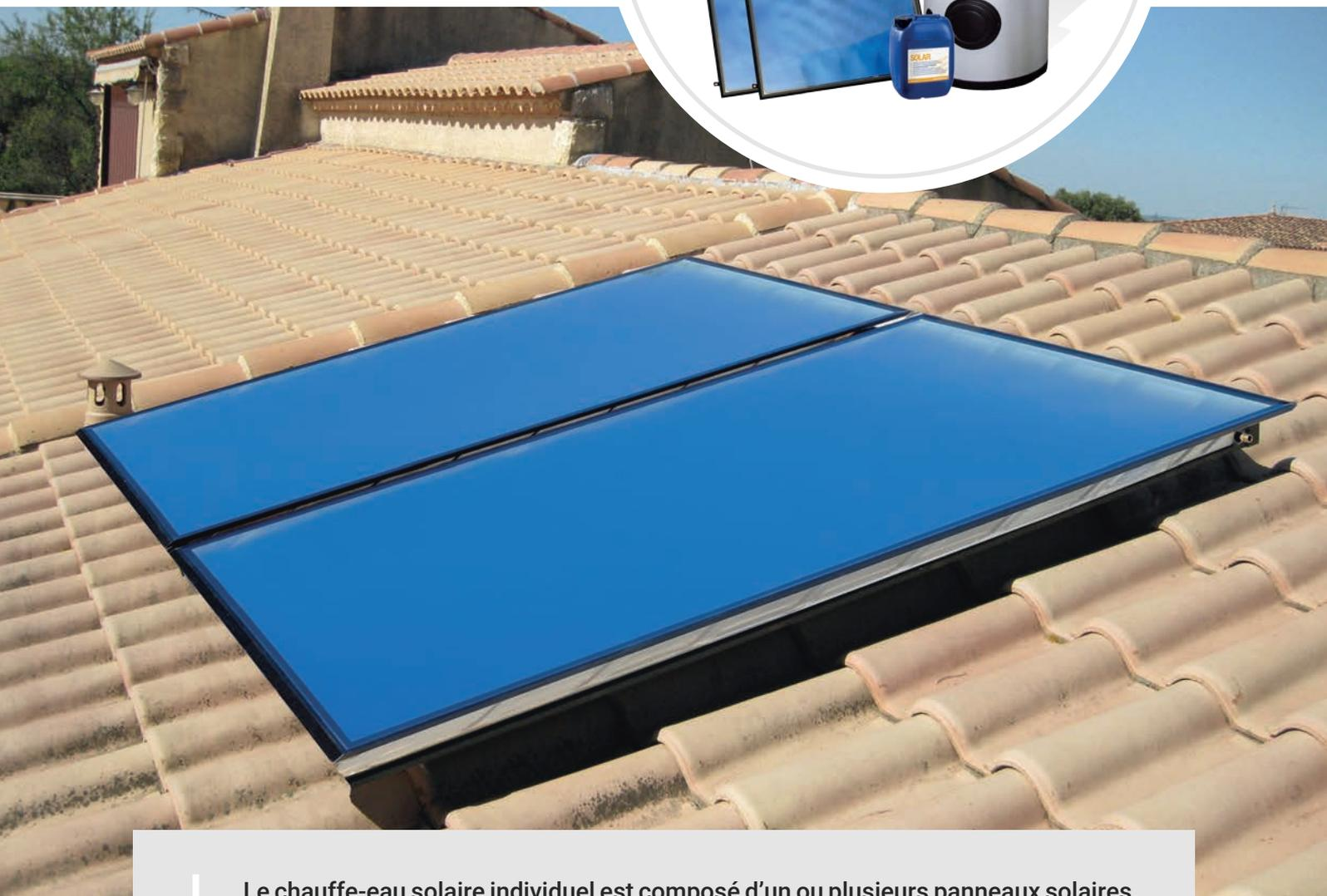
Le chauffe-eau solaire individuel est composé d'un ou plusieurs panneaux solaires, selon la zone géographique et le nombre de personnes habitant dans le logement, d'un ballon de stockage et d'une régulation. Le ballon peut être alimenté par une énergie d'appoint par le biais d'une résistance électrique, une pompe à chaleur ou autres chaudières (gaz, fioul, bois).
